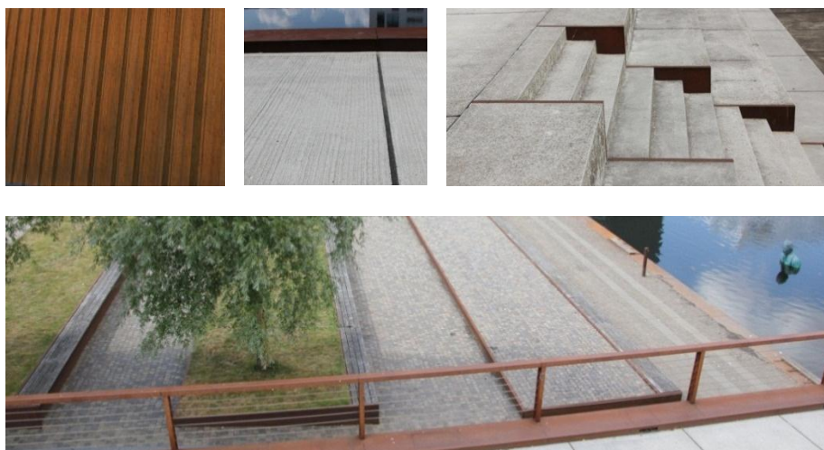
Figur 3-12 Materialer og formsprog for et nyt havnebad skal genspejle havnens karakter og øvrige udtryk. Spuns og beton kan udgøre havnebadets materialer til vægge og gulv. Designguide for Odense Havn – del 1.
