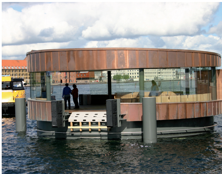
Den fugtbestandige Barmark PT-200 plade anvendt til underkonstruktionen i Opera Pavillionen.
