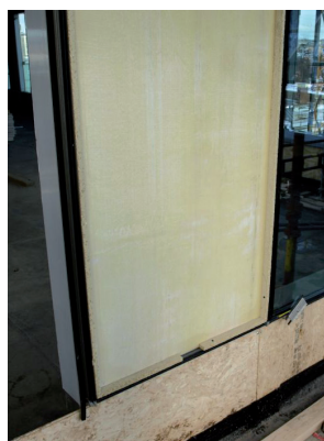
PT-200 i et facadevindue.
