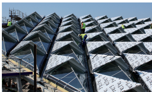
Barmark PT-200 plader anvendt i konstruktionen for ovenlyselementer til Middelfart Sparekasse
